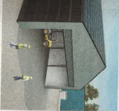
Päikesehalli puhul on päikesepaneelidega kaetud nii katus kui ka seinad. Foto Solarstone
